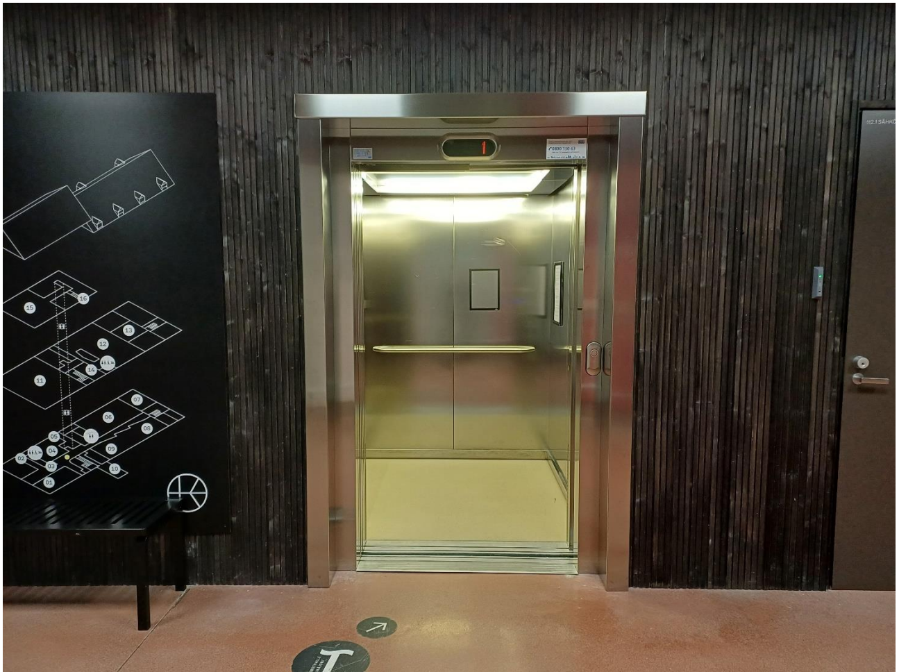
Kuva 6 Hissi ensimmäisen kerroksen käytävältä kuvattuna. Hissin mitat ovat 158 cm x 146 cm.
