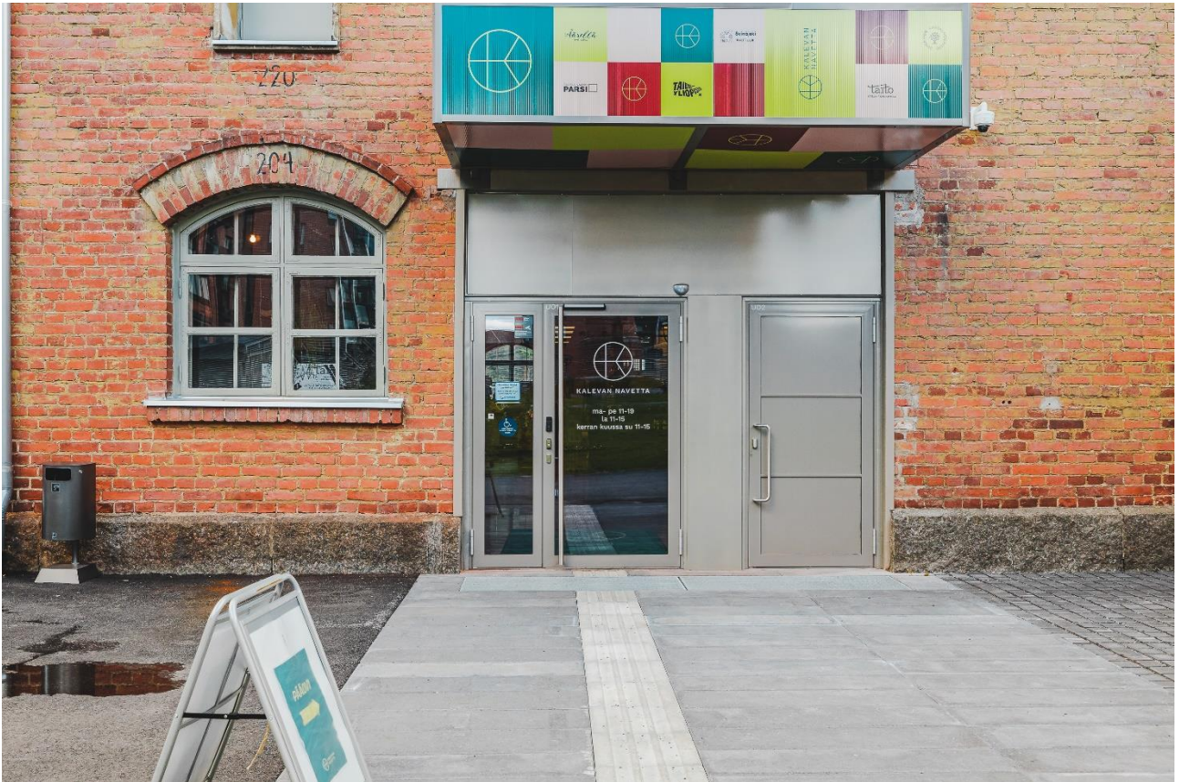
Kuva 3 Kalevan Navetan pääovi. Pääoven yläpuolella on värikäs lippa.
